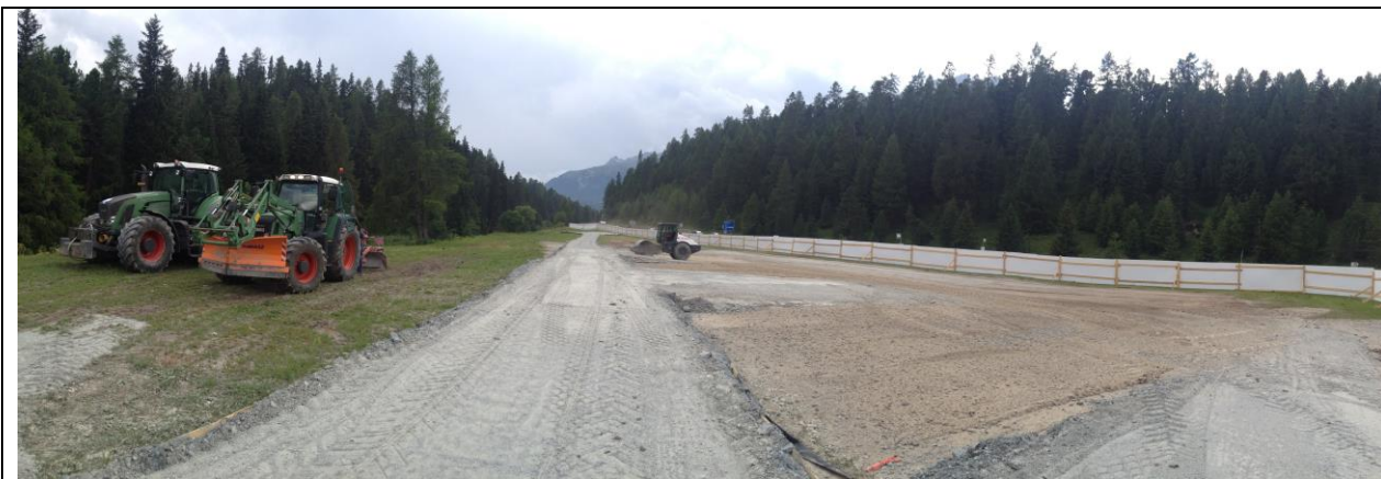
Abb.: Service Center Islas (Bauamt St. Moritz)
