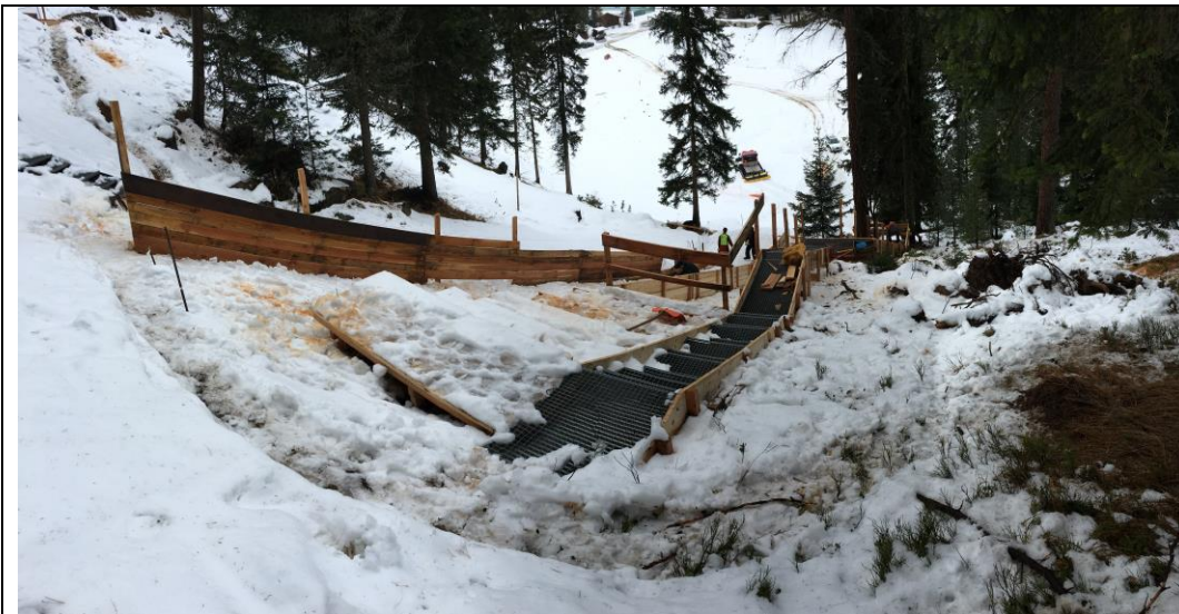
Abb.: Aufbau der Ersatzschanzen nach der erfolgreichen Sanierung (Bauamt St.Moritz)
