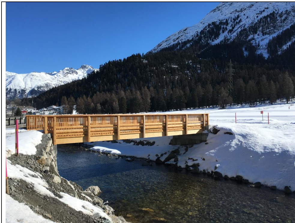
Abb.: Bau der Brücke Islas (Bauamt St. Moritz)
