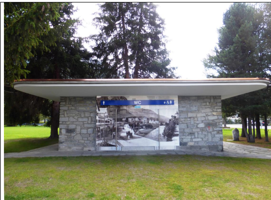
Abb.: Frisch sanierte WC-Anlage Piazza Rosatsch (Bauamt St. Moritz)
