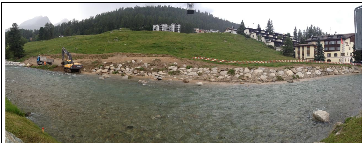
Abb. Revitalisierungsmassnahmen im untern Abschnitt der Etappe I (Bauamt St. Moritz)
