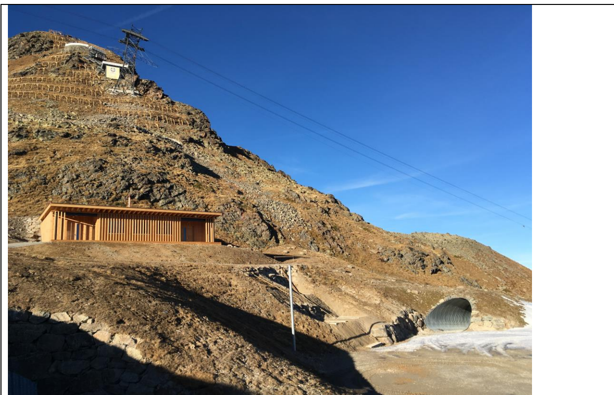
Abb.: Neue Aufwärmstation Damen oberhalb der Bergstation Munt da San Murezzan (Bauamt St. Moritz)
