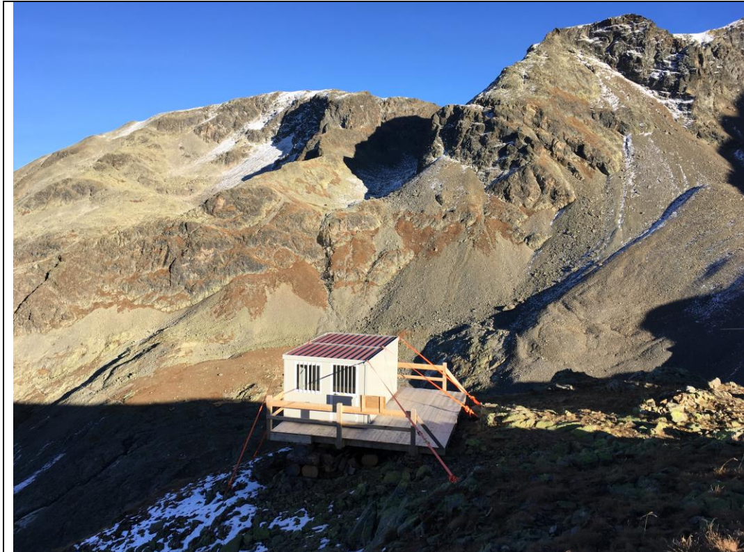
Abb. Plattform Gegenhangkamera mit dem darauf installierten Container (Bauamt St.Moritz)
