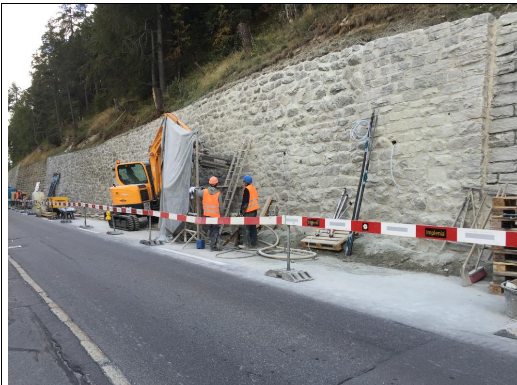
Abb.: Mauersanierungsarbeiten an der Via Somplaz (Bauamt St. Moritz)
