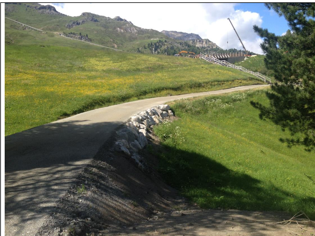
Abb.: Sanierter Abschnitt der Via Alpina mit der neuen talseitigen Böschungssicherung (Bauamt St. Moritz)
