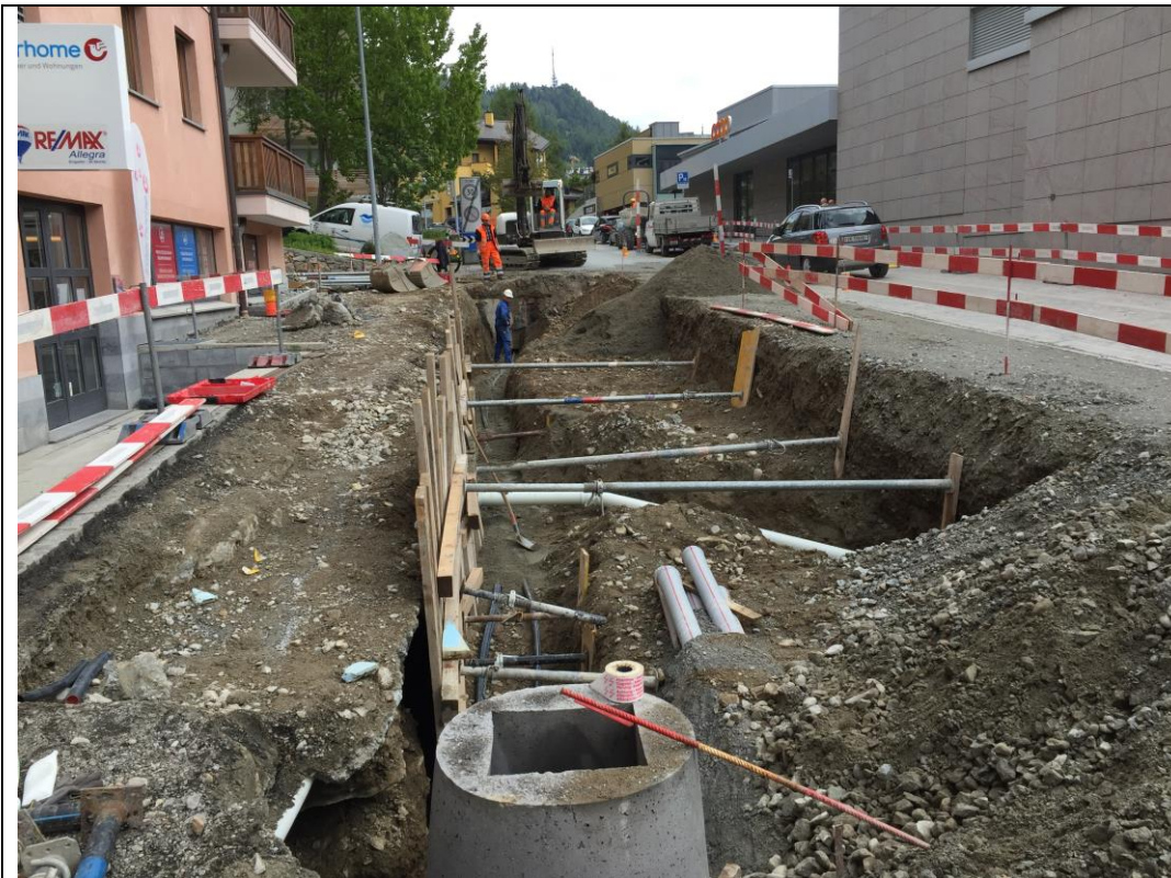
Abb.: Sanierungsarbeiten in der Via dal Bagn (Bauamt St. Moritz)
