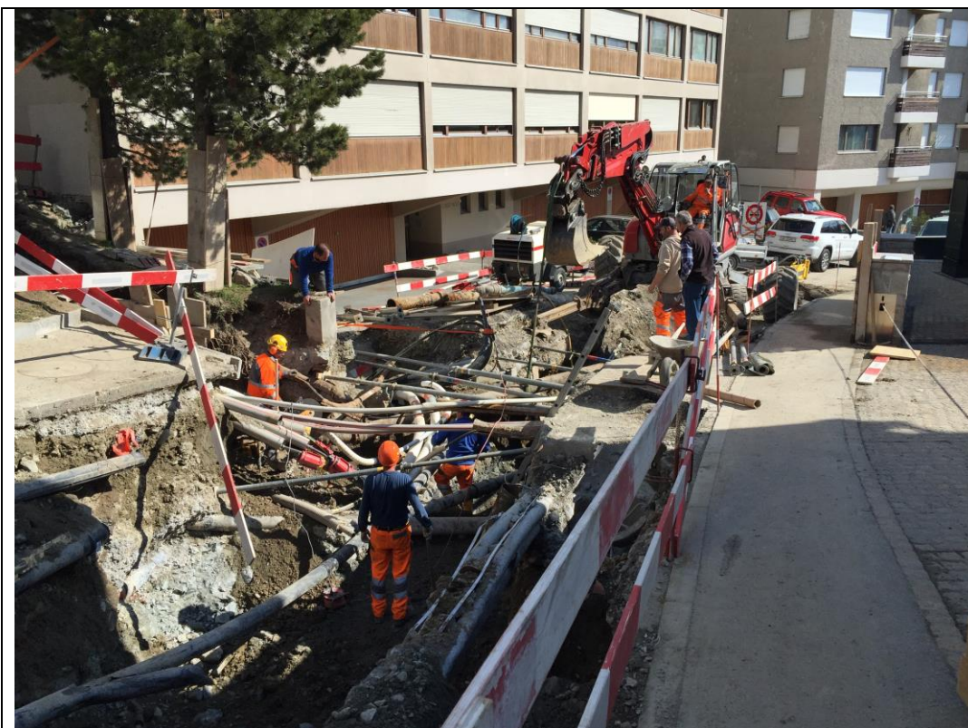
Abb.: Sanierung Leitungsknotenpunkt an der Via Tinus (Bauamt St. Moritz)
