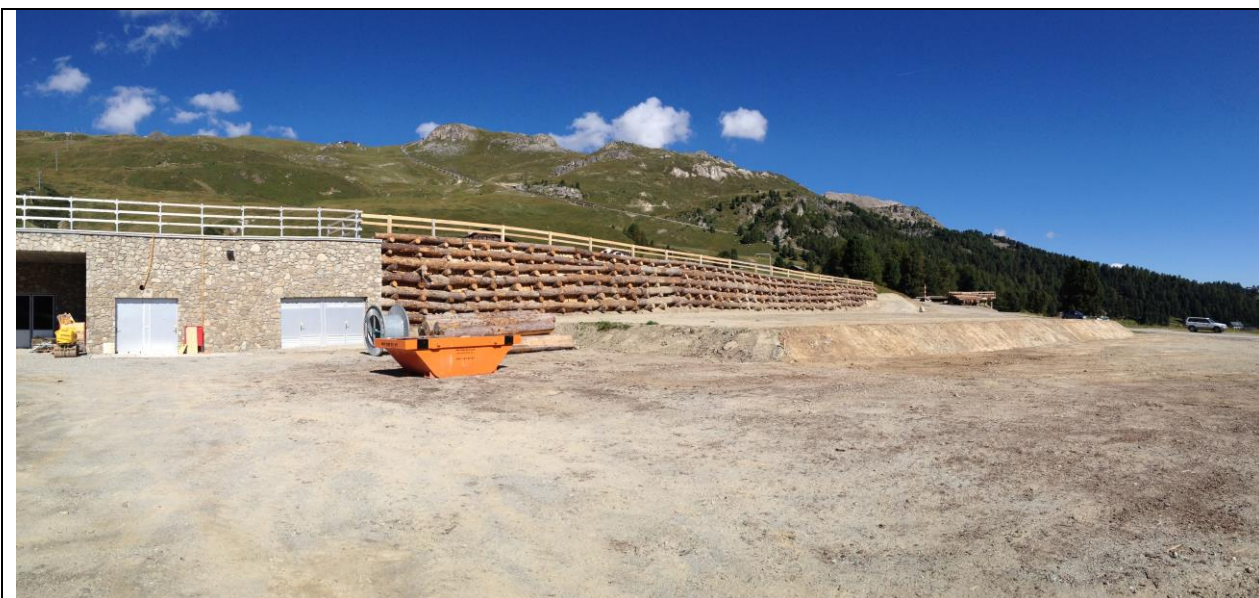
Abb. Holzkasten für die Geländekorrekturen für das Voluntari Zelt (Bauamt St. Moritz)
