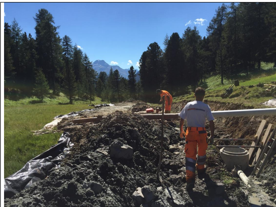
Abb.: Bauarbeiten an der Kanalisation. Rechts die sorgsam ausgelegten Rasensoden und links das nach Bodentyp gelagerte Material (Bauamt St.Moritz)
