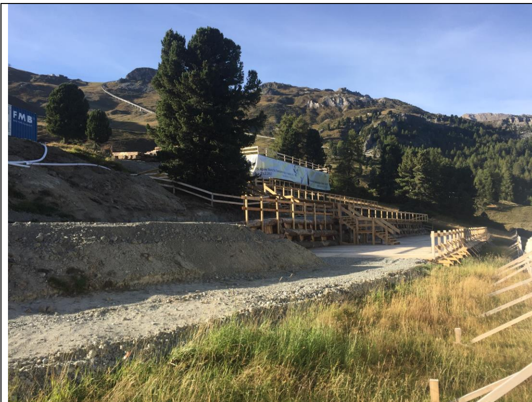
Abb. Fertige Terrassen und Plattform des IBC bei der Übergabe an den WM Verein. (Bauamt St. Moritz)
