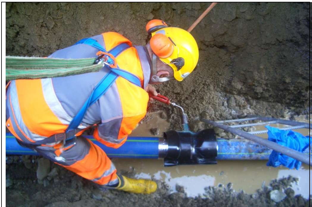
Abb.: Einbau neuer Leitungstyp mit Verbindungsstück (Bauamt St. Moritz)
