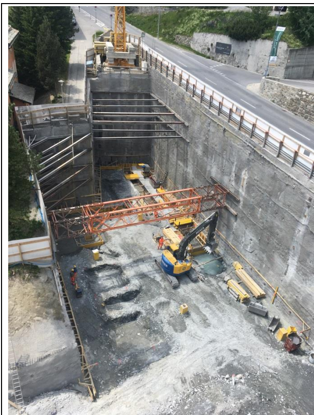
Abb.: Baugrube Annex Bau Grace Hotel (Bauamt St. Moritz)
