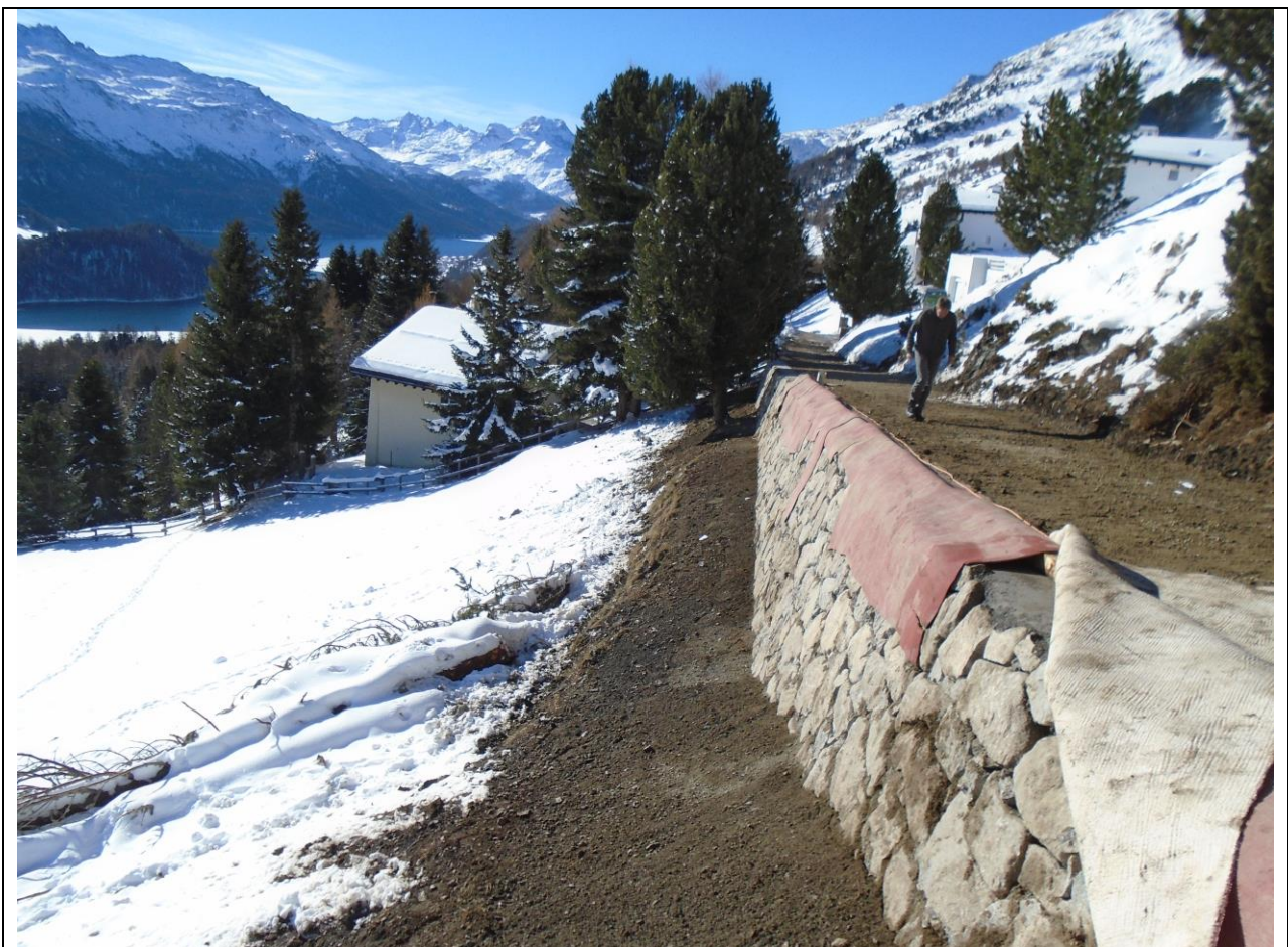
Abb.: Fertig sanierte Mauer Puzzainas vor der Montage des Zauns. Im Schnee sind die Arven erkennbar, welche als Steinschlagschutz im Rahmen der Sofortmassnahmen dort deponiert wurden. (Bauamt St. Moritz)
