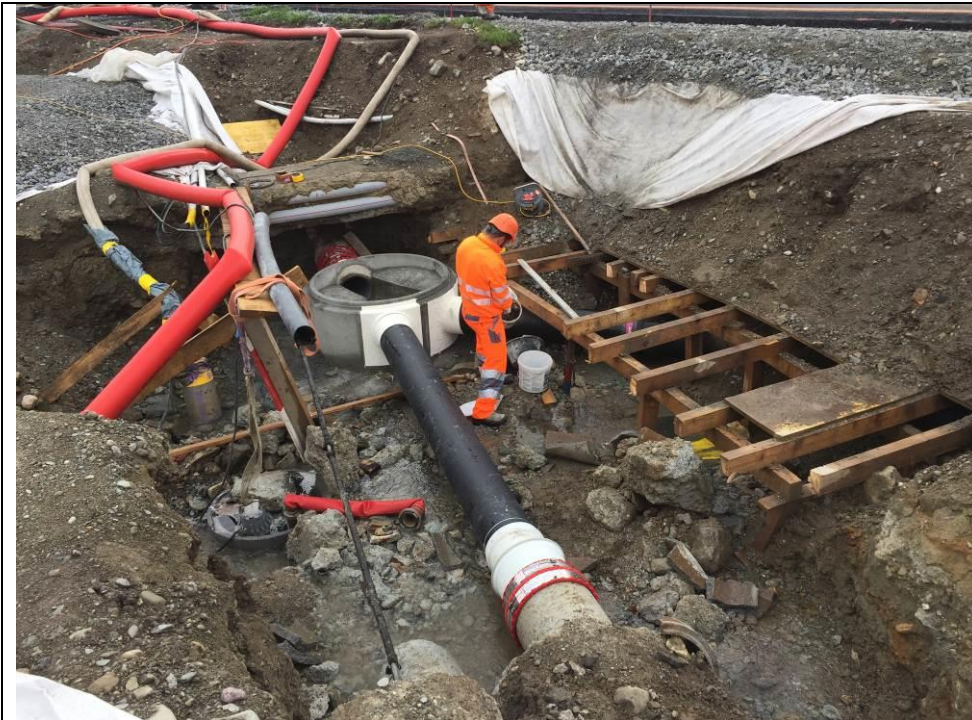
Abb.: Umlegung der Schmutzwasserleitung im Zuge des Projektes Kreisel Signal West (Bauamt St. Moritz)
