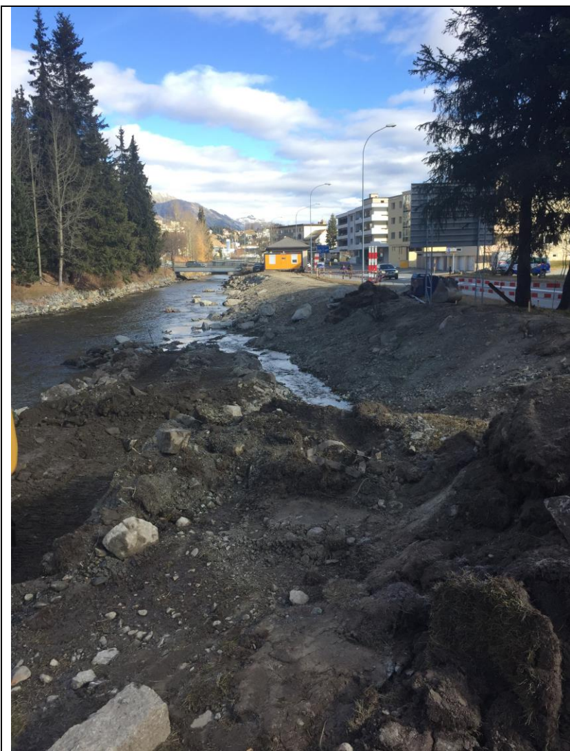
Abb. Revitalisierungsmassnahmen zwischen altem Feuerwehrdepot und Trafostation (Bauamt St. Moritz)
