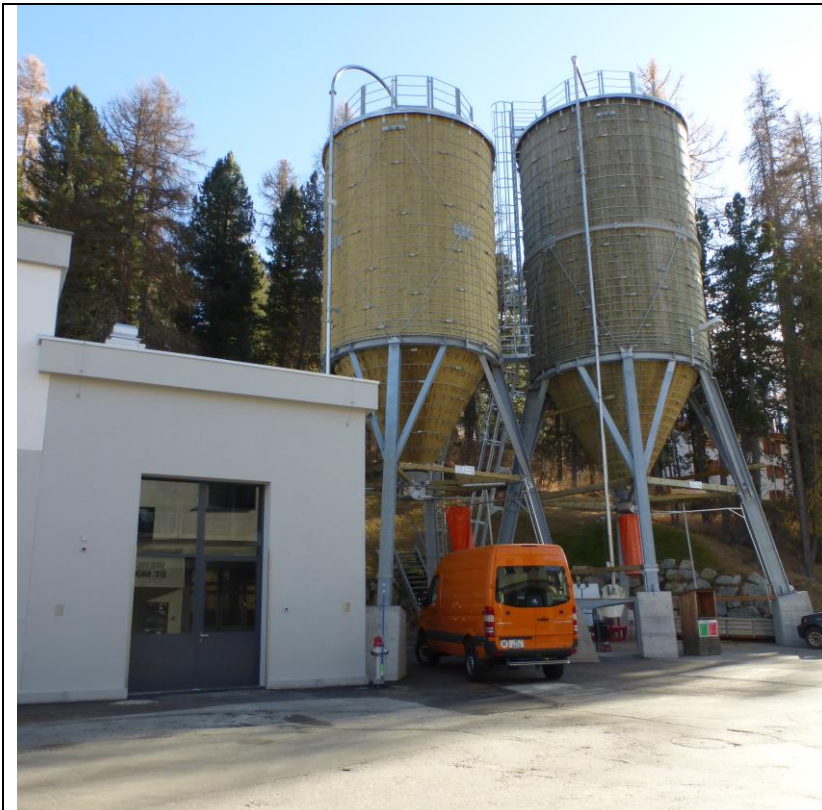
Abb.: Neues Salzsilo und Treibstofflager beim Werkhof des Bauamts (Bauamt St.Moritz)
