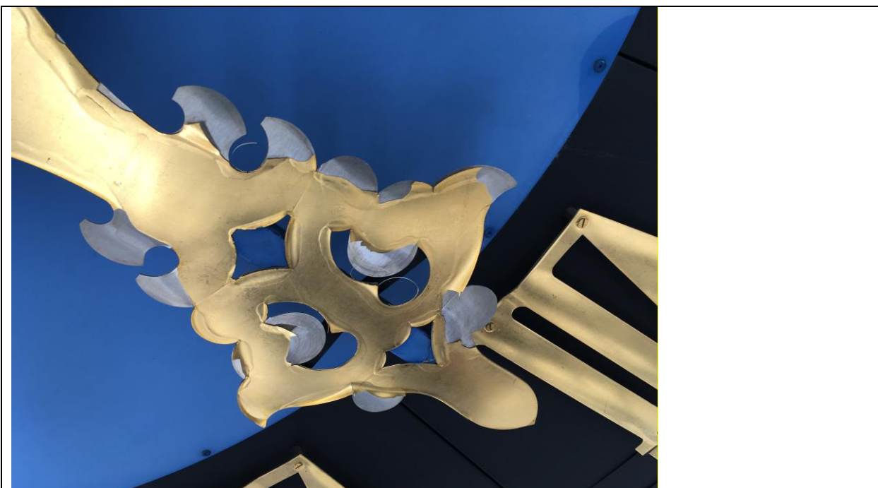
Abb.: Abblätternde Vergoldung an den Zeigern und Verfärbungen am Zifferblatt wahrscheinlich durch eingedrungenes Wasser (Bauamt St. Moritz)
