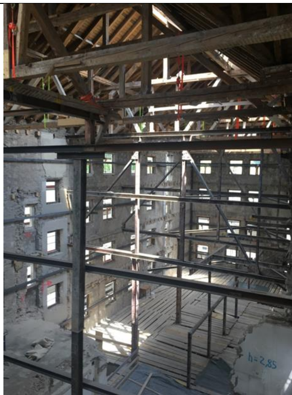
Abb.: Ausgekerntes Grace Hotel (Bauamt St. Moritz)
