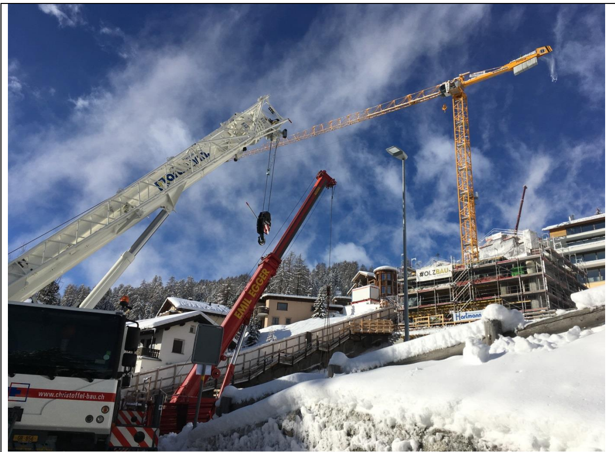
Abb.: Kranmontage Areal Tinus (Bauamt St. Moritz)
