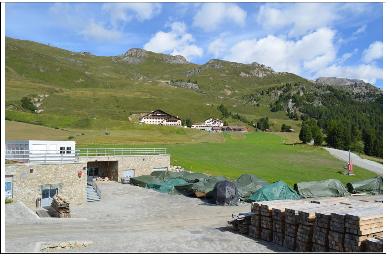
Abb. Holzkasten für die Geländekorrekturen für das Voluntari Zelt nach der Vollendung und nach dem Rückbau (Bauamt St. Moritz)
