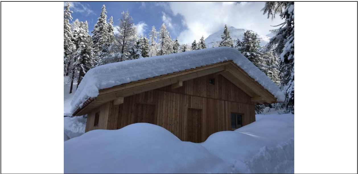
Abb.: Das neue Pfadheim mit seiner Lärchenholzschalung integriert sich bestens in die winterliche Landschaft (Bauamt St. Moritz)
