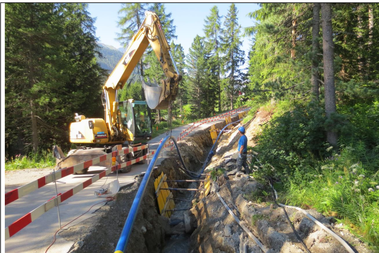
Abb.: Einzug der neuen Leitung in der Via Palüd (Bauamt St.Moritz)
