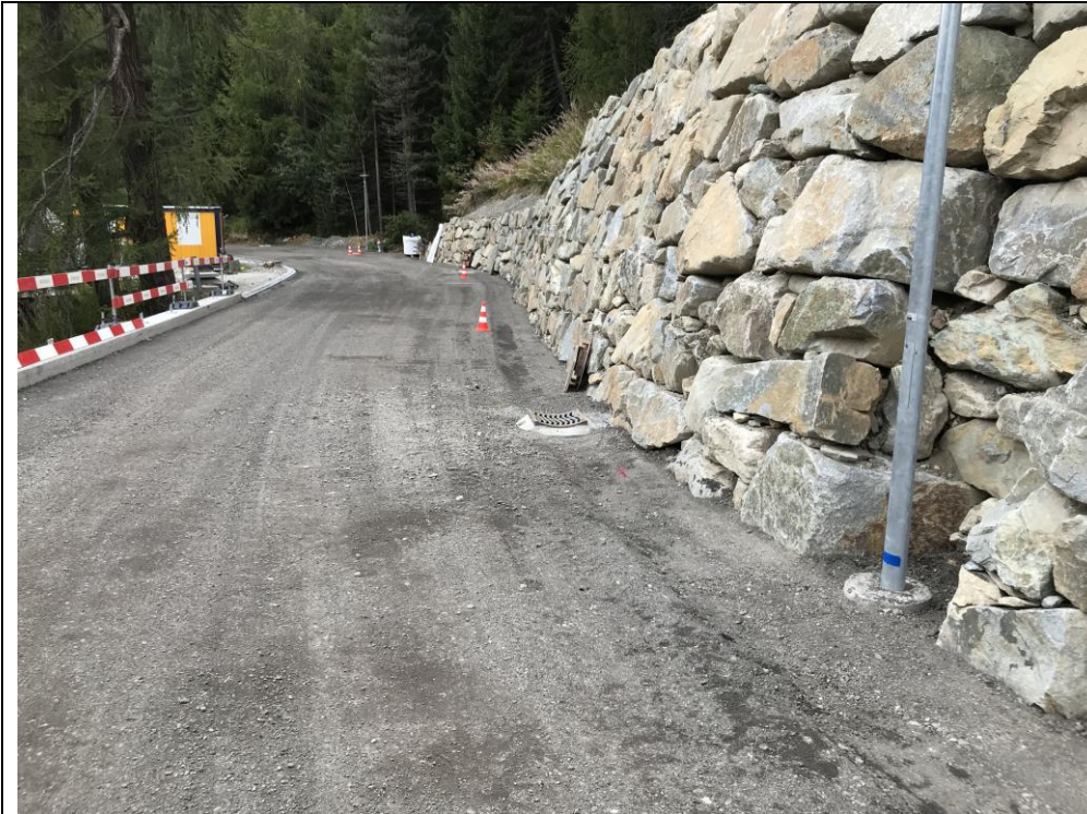
Abb.: Ausgebaute Via Palüd vor dem Einbau des Belages (af Toscano)
