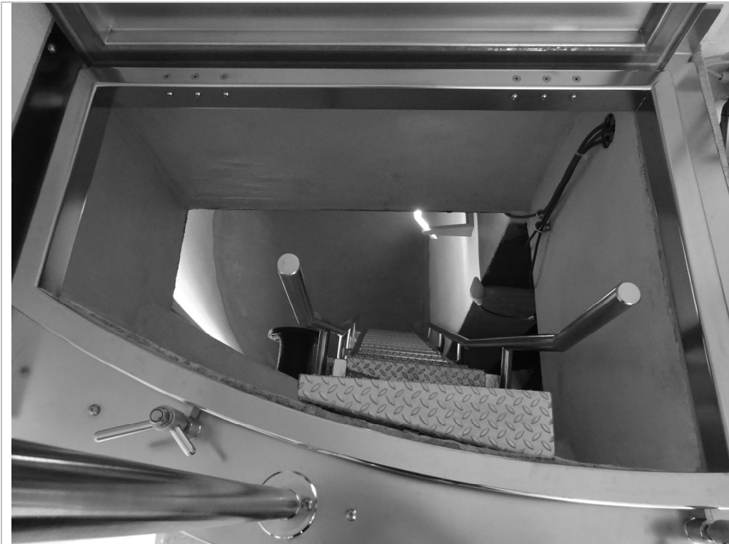
Abb.: Blick ins frisch sanierte Reservoir (Bauamt St. Moritz)
