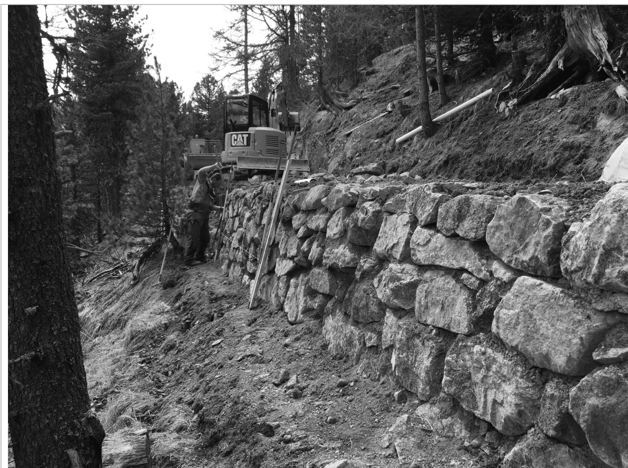
Abb.: Sanierungsarbeiten an den talseitigen Stützmauern God Laret (Bauamt St. Moritz)
