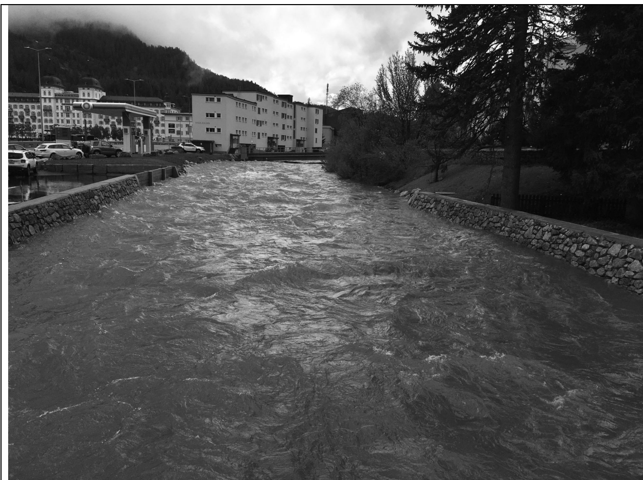
Abb.: Die im Rahmen der Hochwasserschutzmassnahmen umgesetzten Bauten bewährten sich in jeder Hinsicht (Bauamt St. Moritz)
