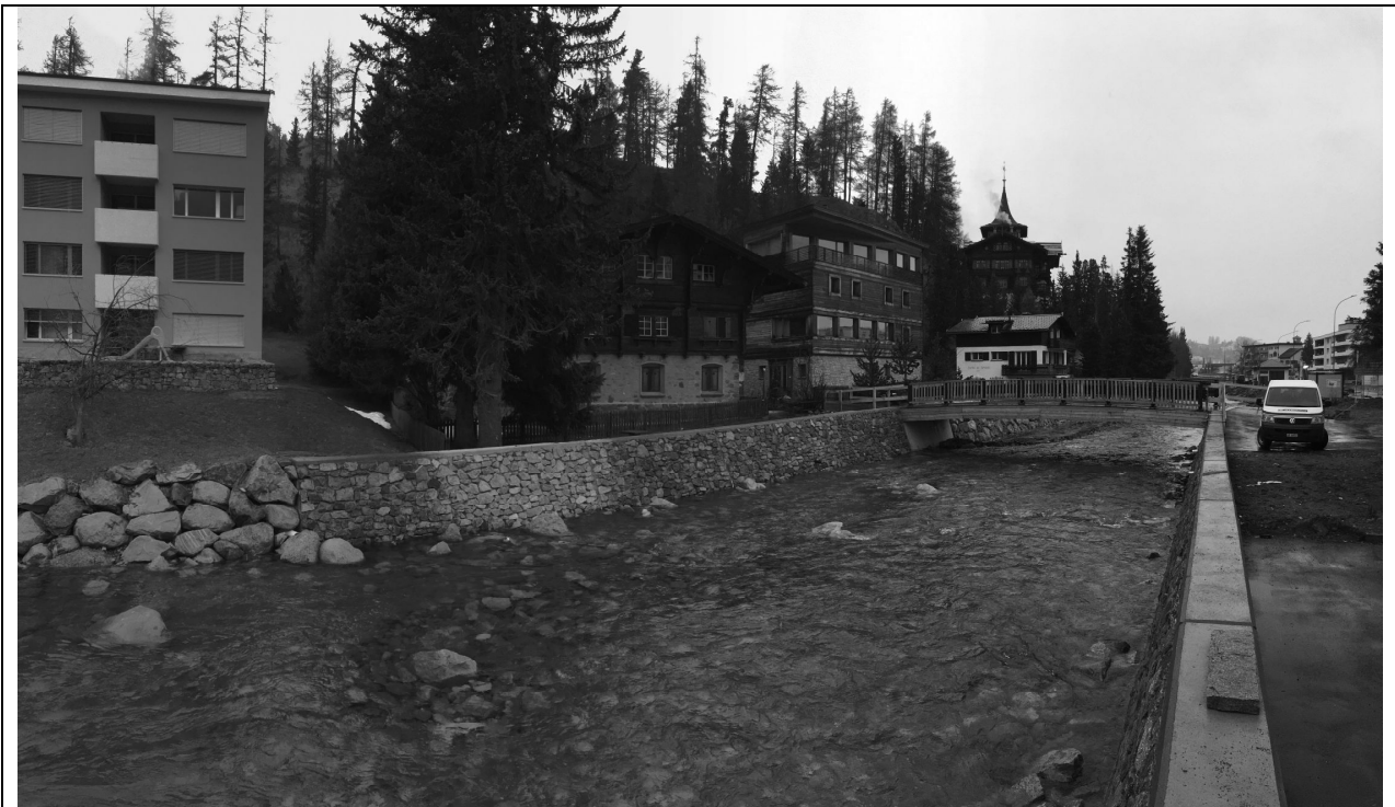
Abb.: Abschlussarbeiten am Inn Etappe II ( Bauamt St. Moritz)
