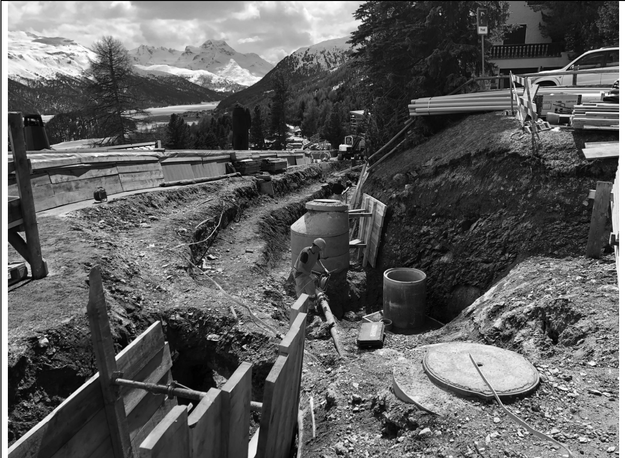
Abb.: Sanierungsarbeiten in der Via Marguns (Bauamt St. Moritz)
