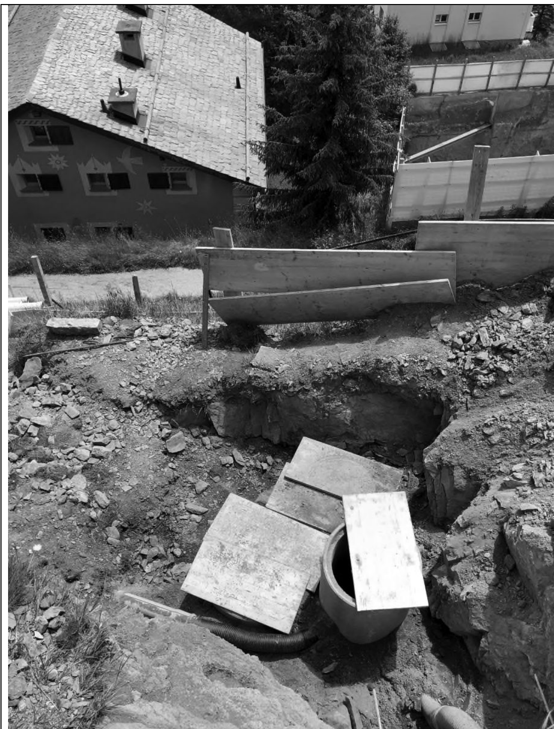
Abb.: Schwierige Bauarbeiten Davous Plaun (Bauamt St. Moritz)
