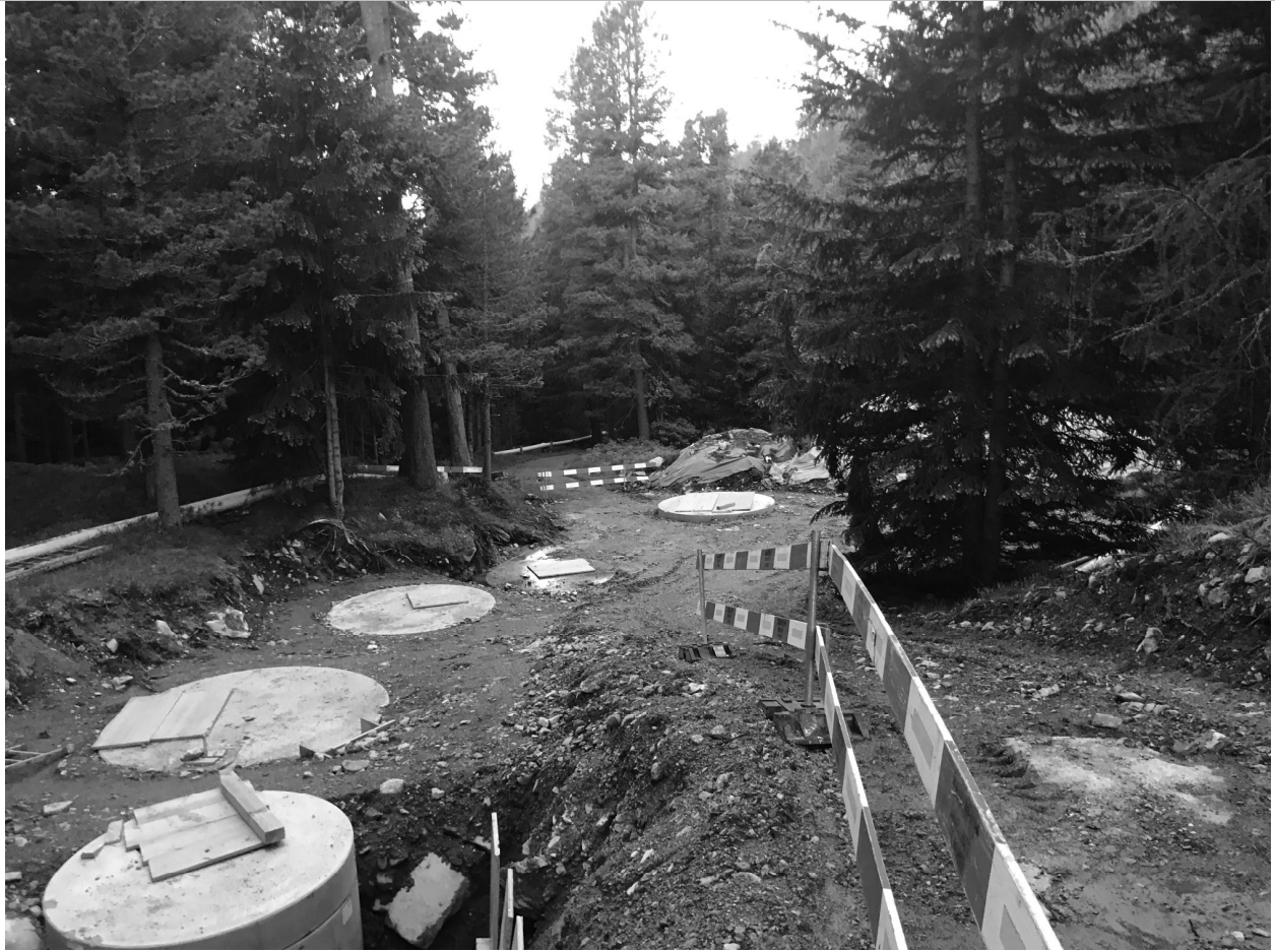
Abb.: Strassenabwasserreinigungsanlage nach dem Einbau (AF Toscano)
