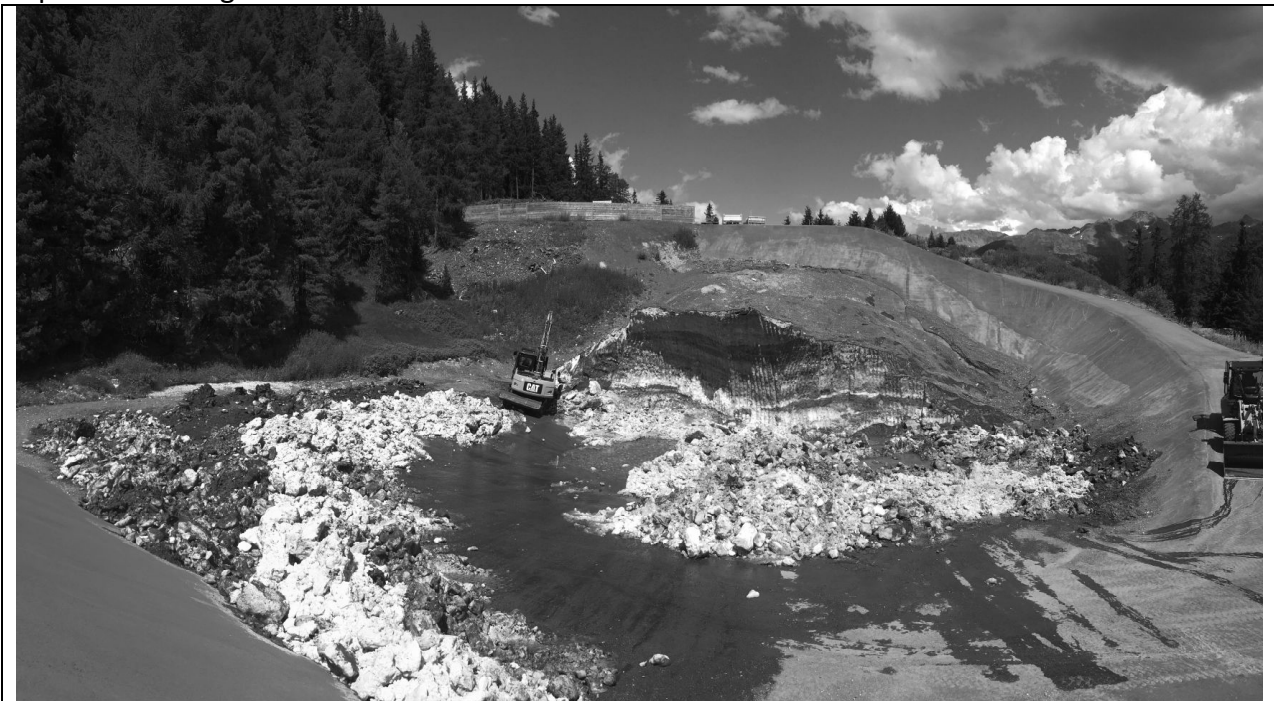
Abb.: Durch das aktive Verteilen des deponierten Schnees kann das Abschmelzen gefördert werden (Bauamt St. Moritz)
