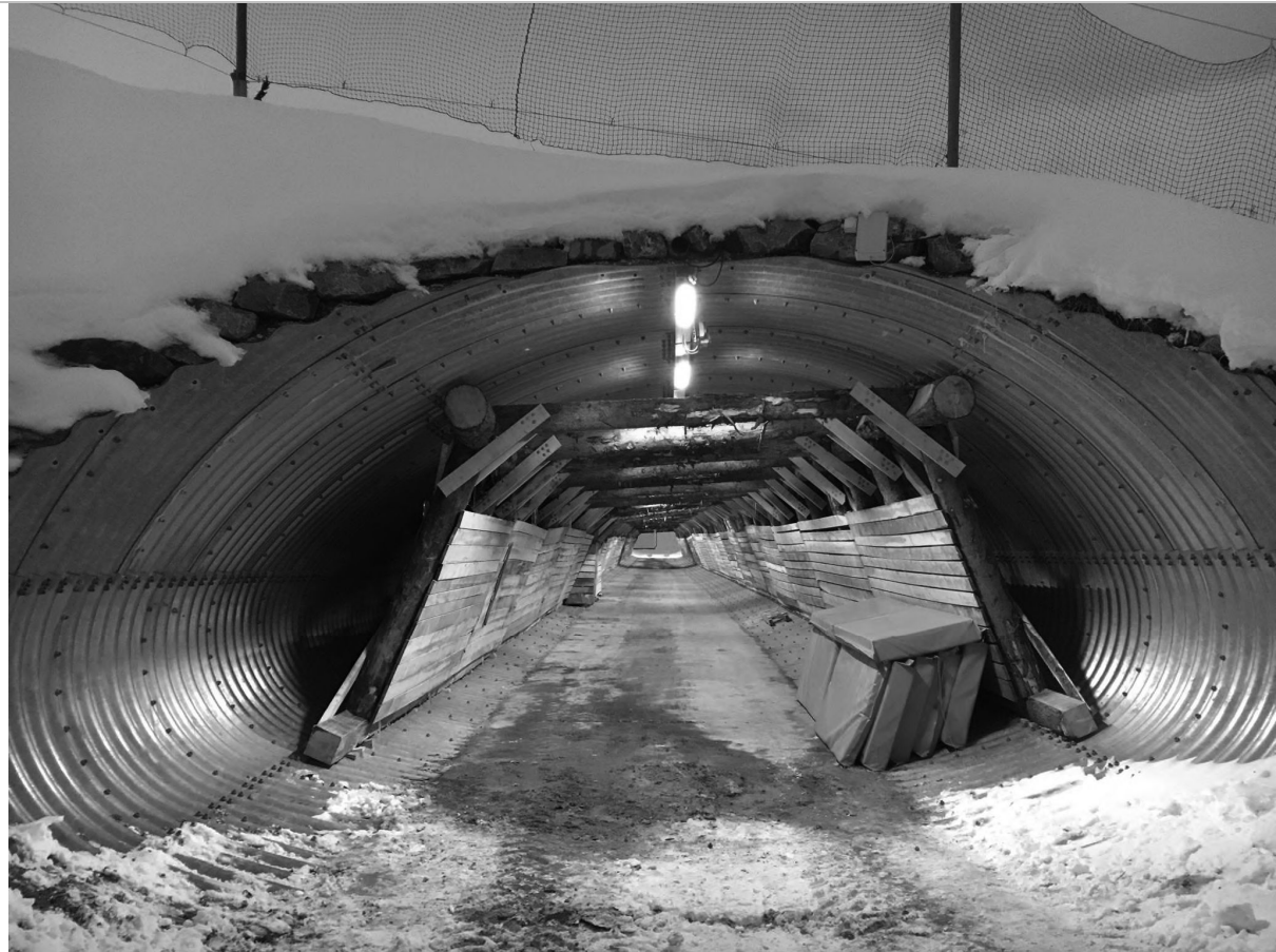
Abb.: Skitunnel Lärchenweg nach dem Einbau des Stützsystems (Bauamt St. Moritz)
