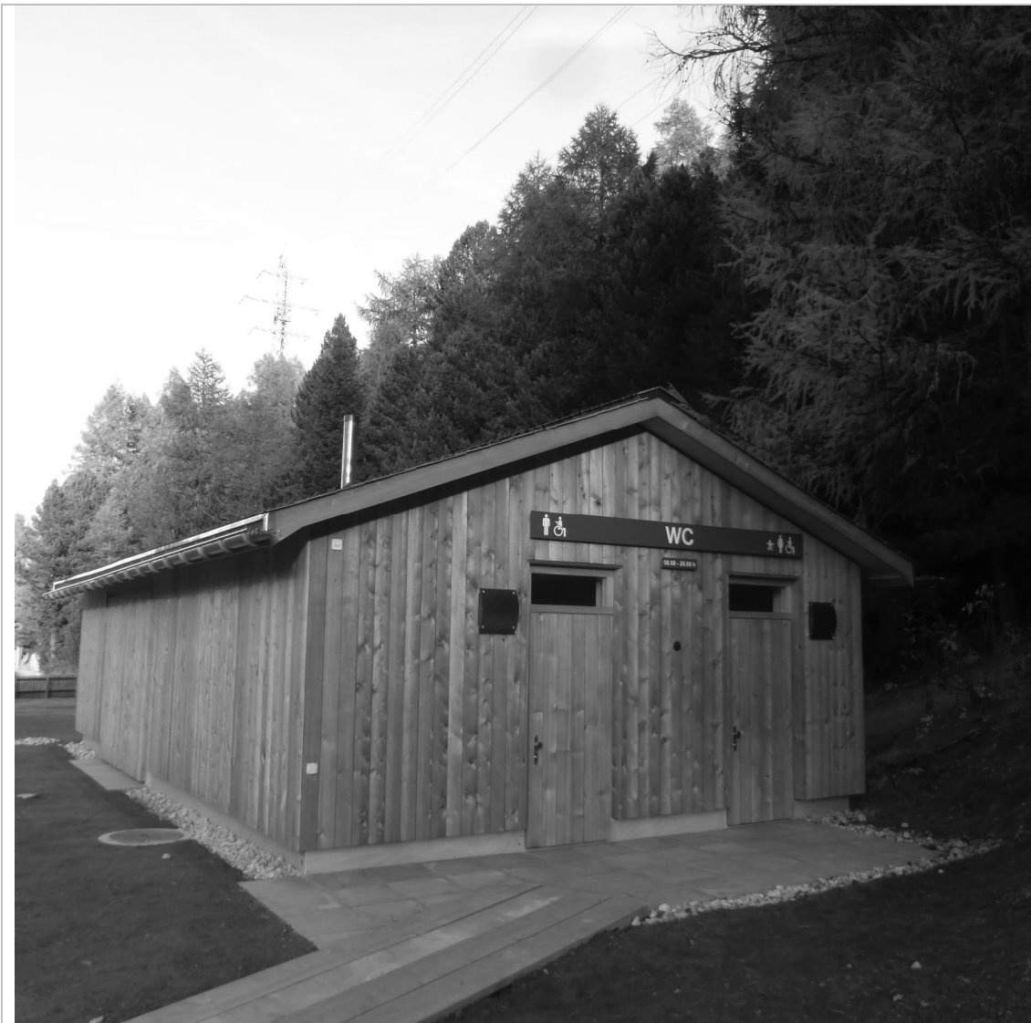
Abb.: Neue WC-Anlage beim Kinderparadies (Bauamt St. Moritz)
