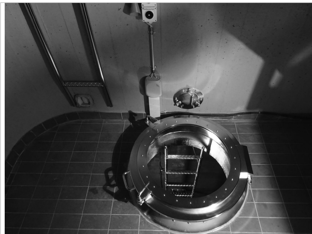
Abb.: Neuer Einstieg ins Reservoir Mauritius (Bauamt St. Moritz)
