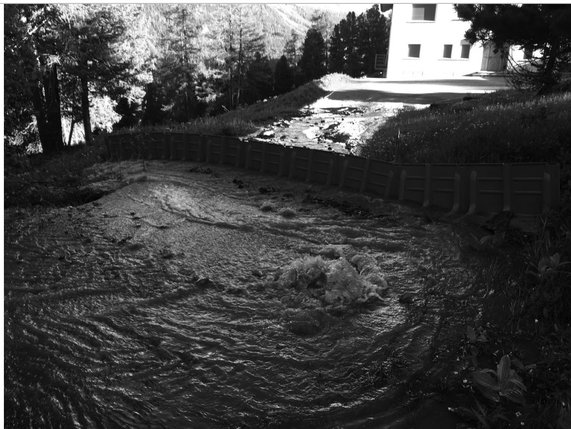
Abb.: Die punktuelle Überschwemmung wegen einer Verklausung eines privaten Durchlasses konnte durch den Einsatz der neuen Hochwasserschutz Elemente «Boxwall» sehr rasch eingedämmt werden. (Bauamt St. Moritz)
