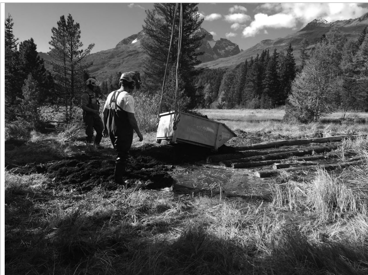
Abb. Nach dem Einbau der Spundwände werden diese überdeckt, damit diese unter Ausschluss von Luft ihre Wirkung möglichst lange beibehalten können (Bauamt St. Moritz)
