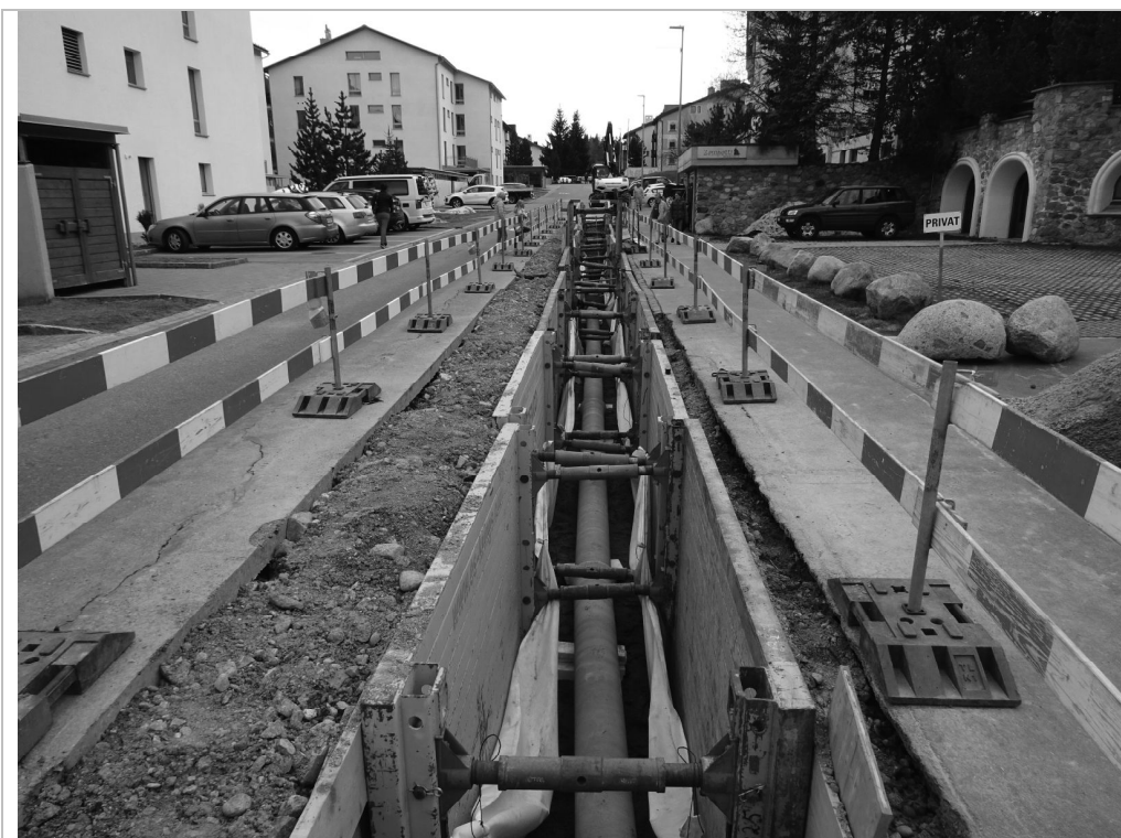
Abb.: Die neue Hauptleitung nach dem Einmessen und vor dem Eindecken (Bauamt St. Moritz)
