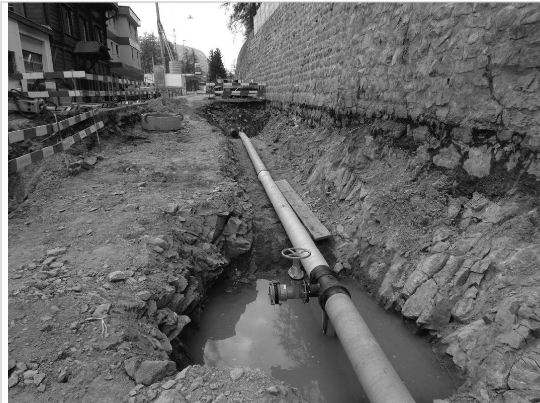
Abb.: Neu Wasserleitung in der Via Somplaz vor dem Setzen des Schieberschachtes (Bauamt St. Moritz)
