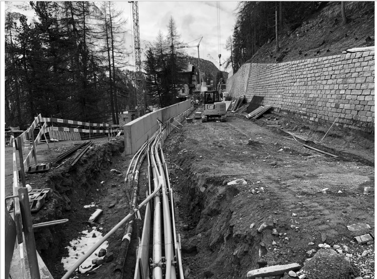
Abb.: Totalsanierung Via Somplaz (Bauamt St. Moritz)
