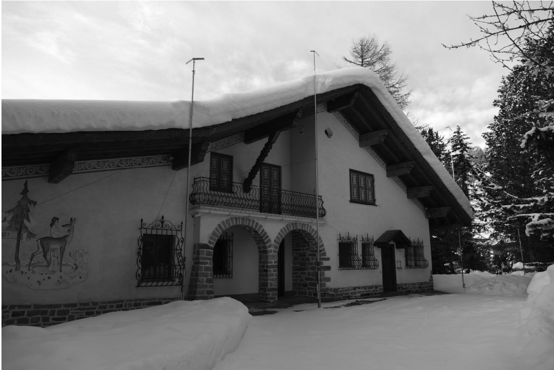
Abb. Baugespann eines privaten Bauvorhabens für den Abbruch und Wiederaufbau eines altrechtlichen Wohnhauses in Verbindung mit einer Erweiterung von 30 % der vorbestehenden HNF (Bauamt St. Moritz)
